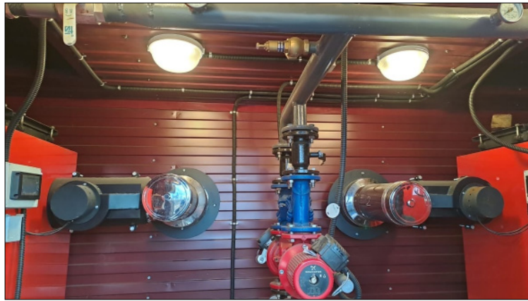
📍 Модульнай робот-хочуол контейнер иһигэр турар.
